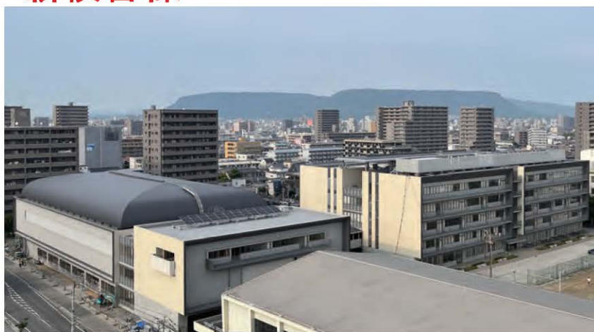
■新校舎の外観と建設中の体育館
